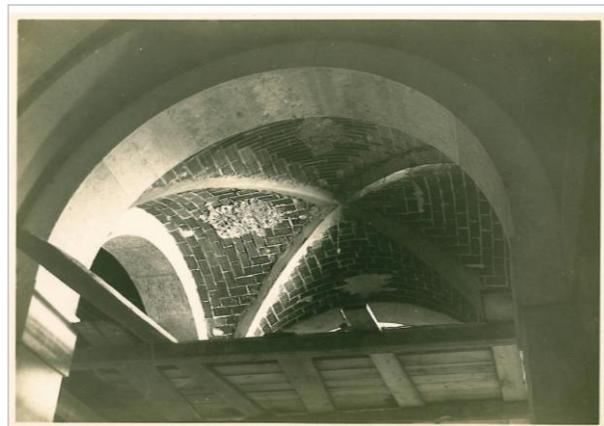
*Struttura in cemento armato della copertura e realizzazione delle volte in mattoni – Dettaglio di una volta a crociera
