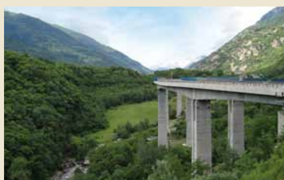
Vista prima del deposito dei materiali
